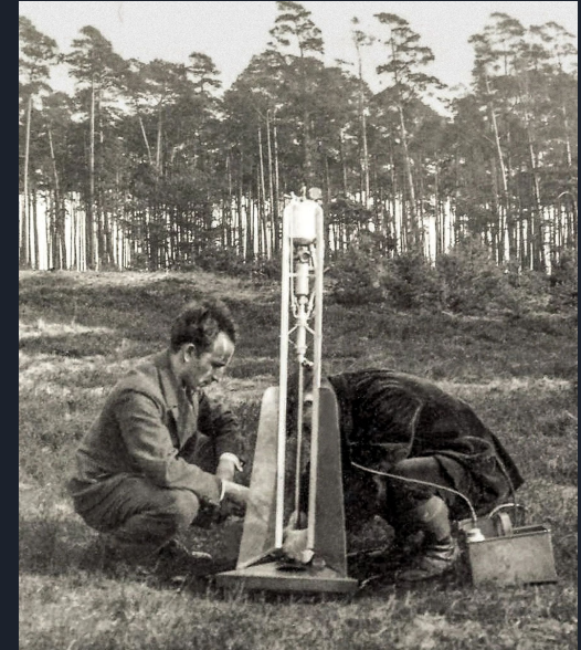
Die Startvorbereitung der von Johannes Winkler entwickelten Flüssigkeitsrakete auf dem Kühnauer Exerzierplatz am 18. April 1931 ist in vollem Gange. Im Ergebnis wird der erste Höhenweltrekord erzielt. Fotos: Sammlung Erfurth
